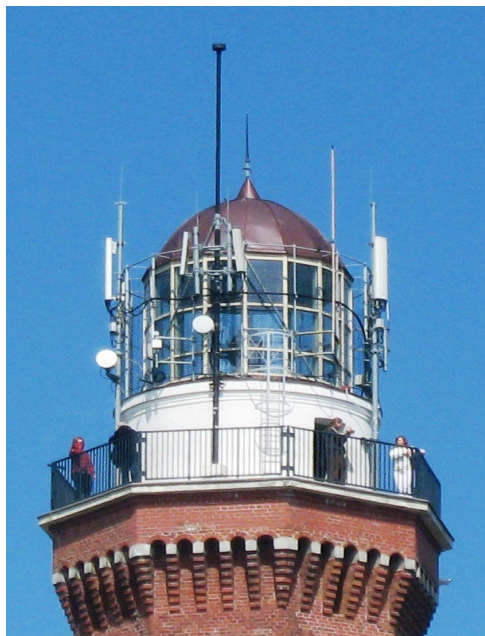
Fotografia VIII.2. Latarnia morska w Niechorzu
